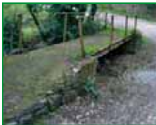
Il ponte sull'affluente del Mugnone
